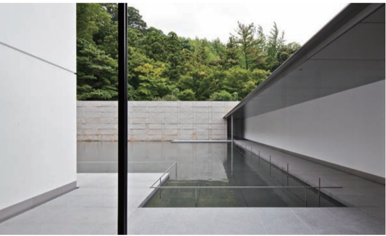
鈴木大拙館 水鏡の庭と外部回廊・石積み 設計:谷口吉生 ©D.T. Suzuki Museum
